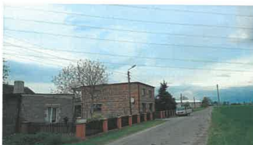
Budynek Markowice 15 w przęśle 175 - 176
