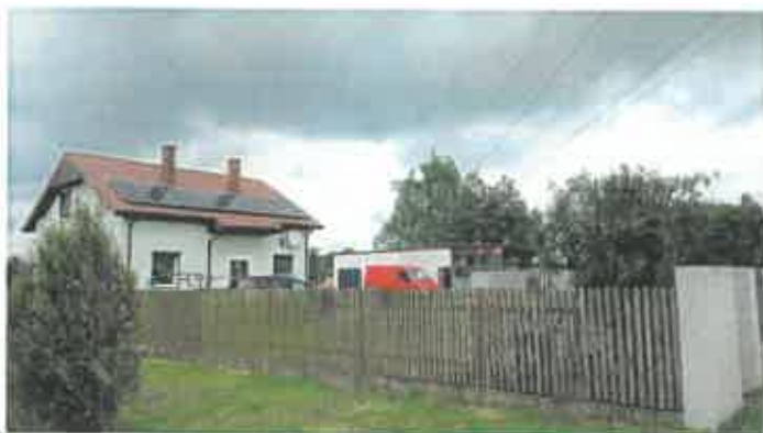
Budynek nr 14A
