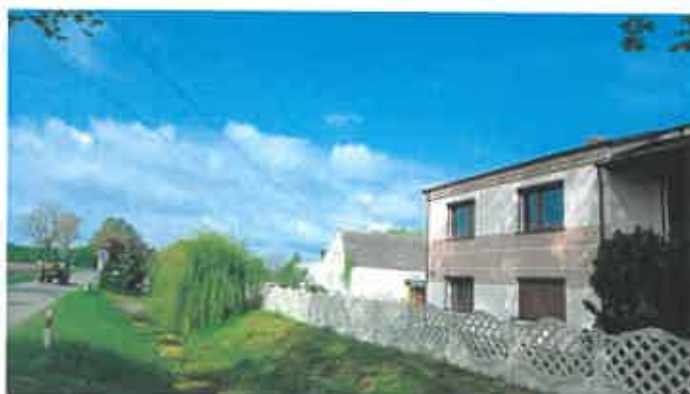
Budynek nr 16a
