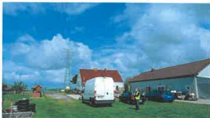
Budynek nr 67 przy ulicy Kaliskiej
