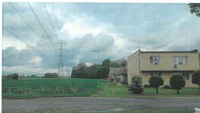
Budynek nr 37a
