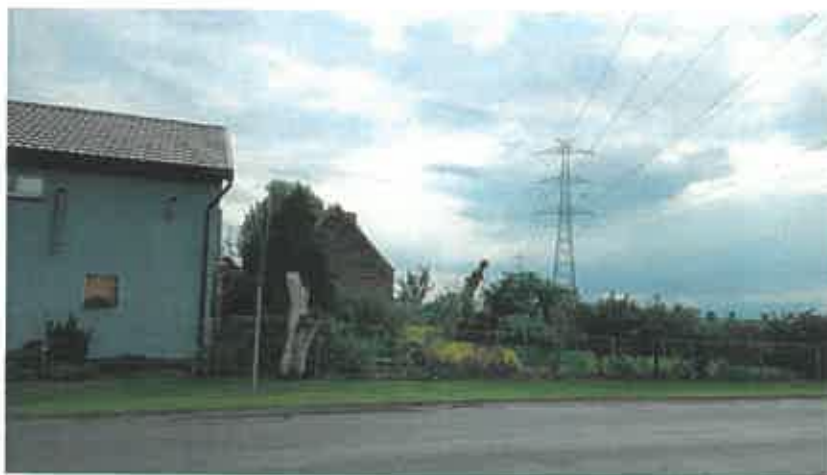
Budynek Krerowo 1 w przęsle 179 - 180
