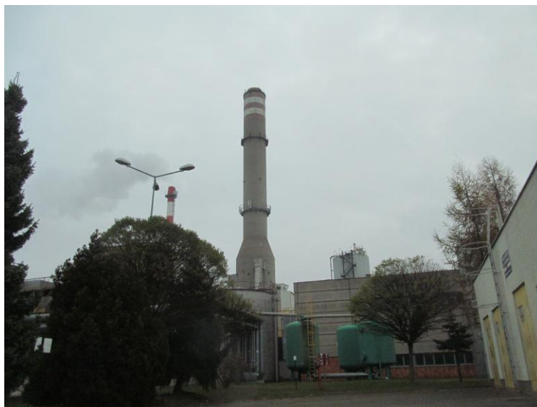
Zał. nr 1: Widok ogólny instalacji radiokomunikacyjnej.
