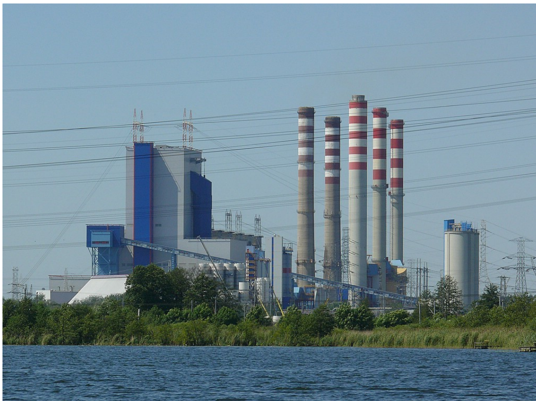
Zdjęcie 2. Elektrownia Pątnów. Źródło: https://commons.wikimedia.org/wiki/File:Elektrownia_P%C4%85tn%C3%B3w.jpg [dostęp: 12.02.2022 r.]
