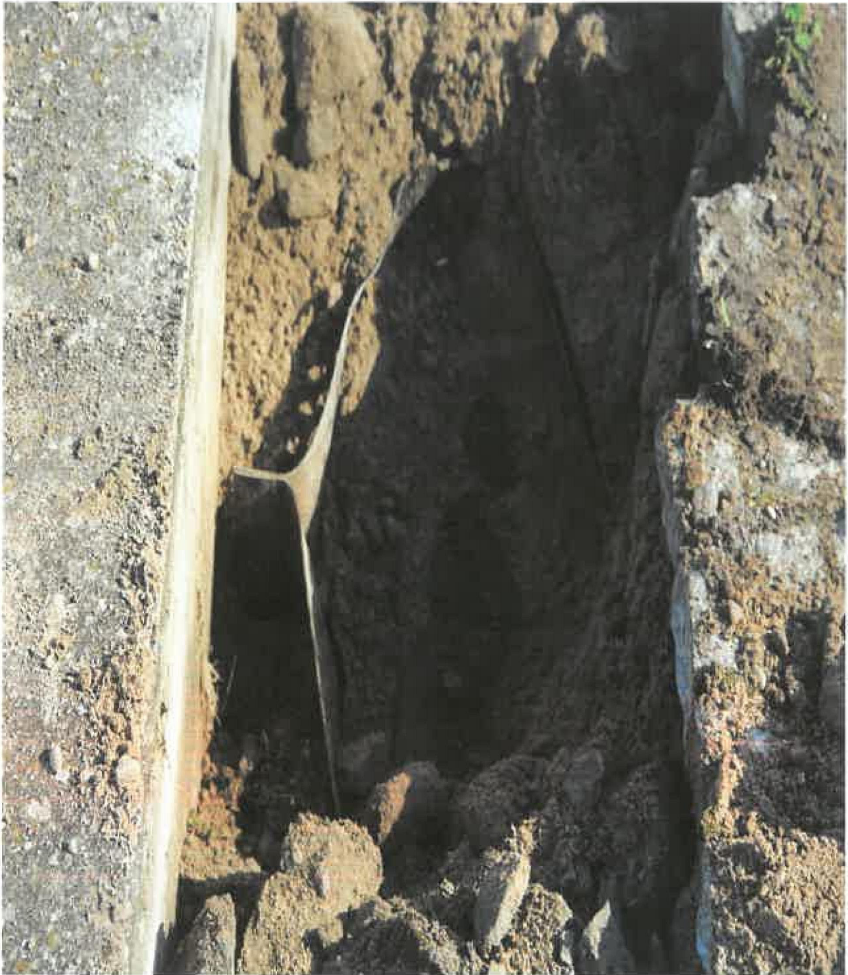
wyflukanie gruntu /3,0m x 1,5m i głębokości około 1,5m,/. .
