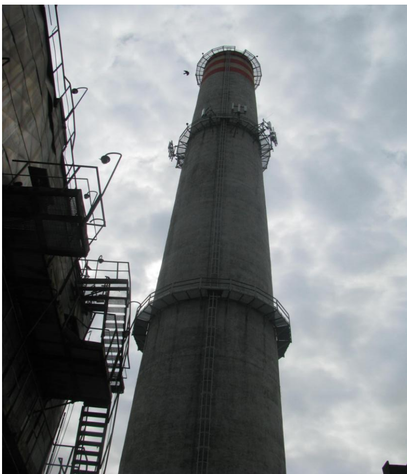
Zał. nr 1: Widok ogólny instalacji radiokomunikacyjnej.
