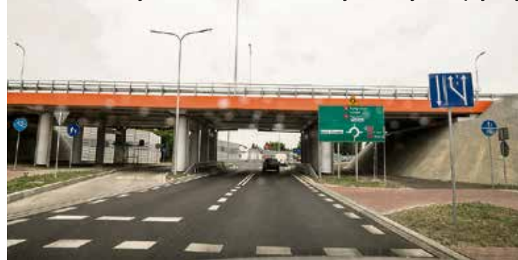
Wiadukt na skrzyżowaniu ulic: Warszawskiej, Kolskiej i Europejskiej
