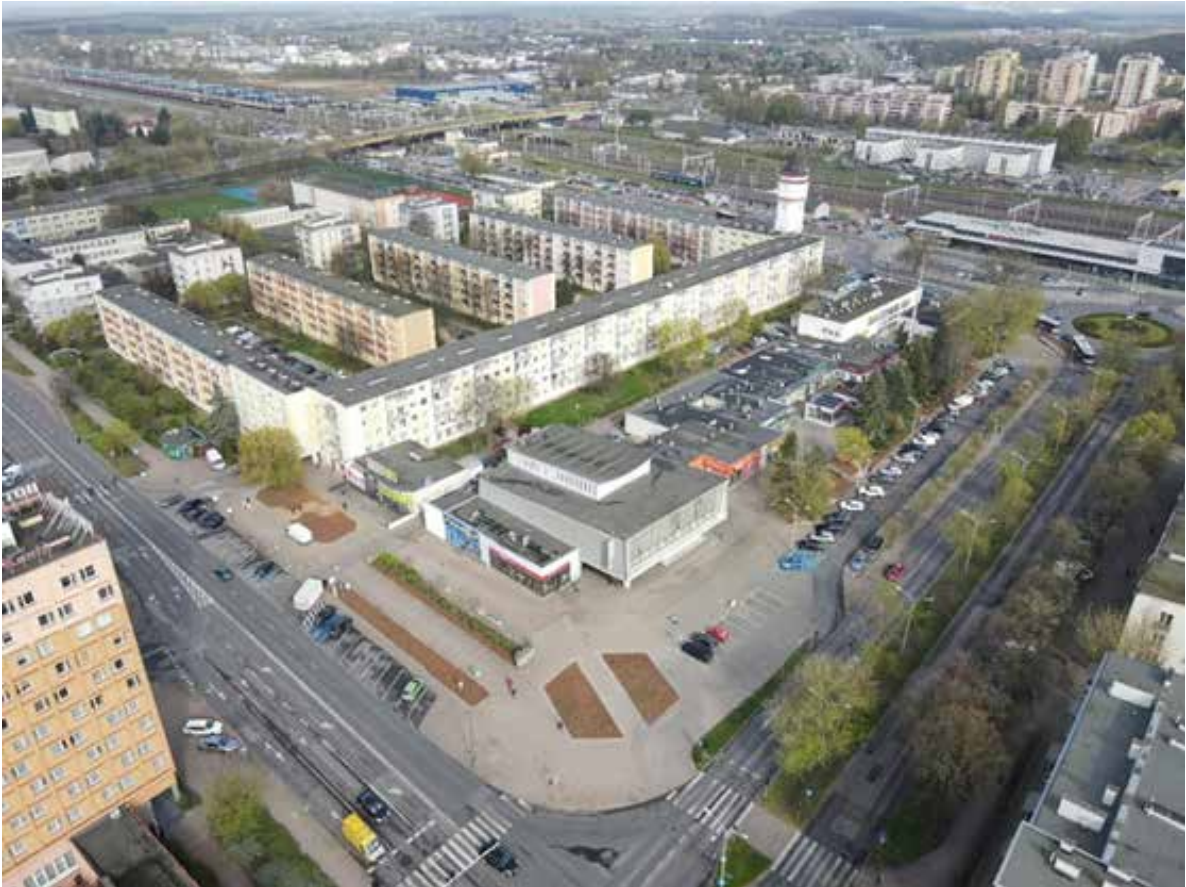
DWORCOWA STAN PO REALIZACJI 2024
