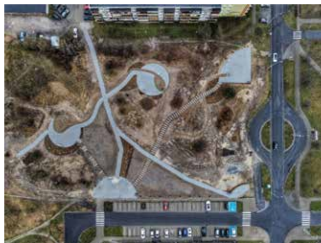
W TRAKCIE REALIZACJI
