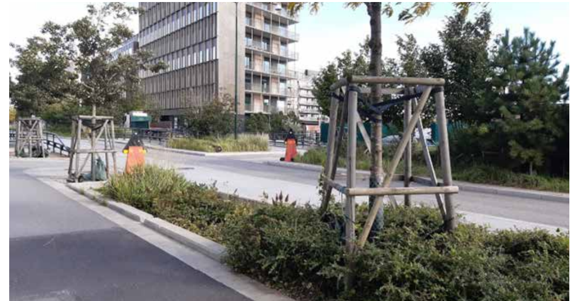
Ogród deszczowy ograniczony krawężnikami betonowymi. Woda do ogrodów wpływa przez specjalnie wykonane obniżenia w krawężnikach, ulica w dzielnicy Västtra Hamnen Malmö
