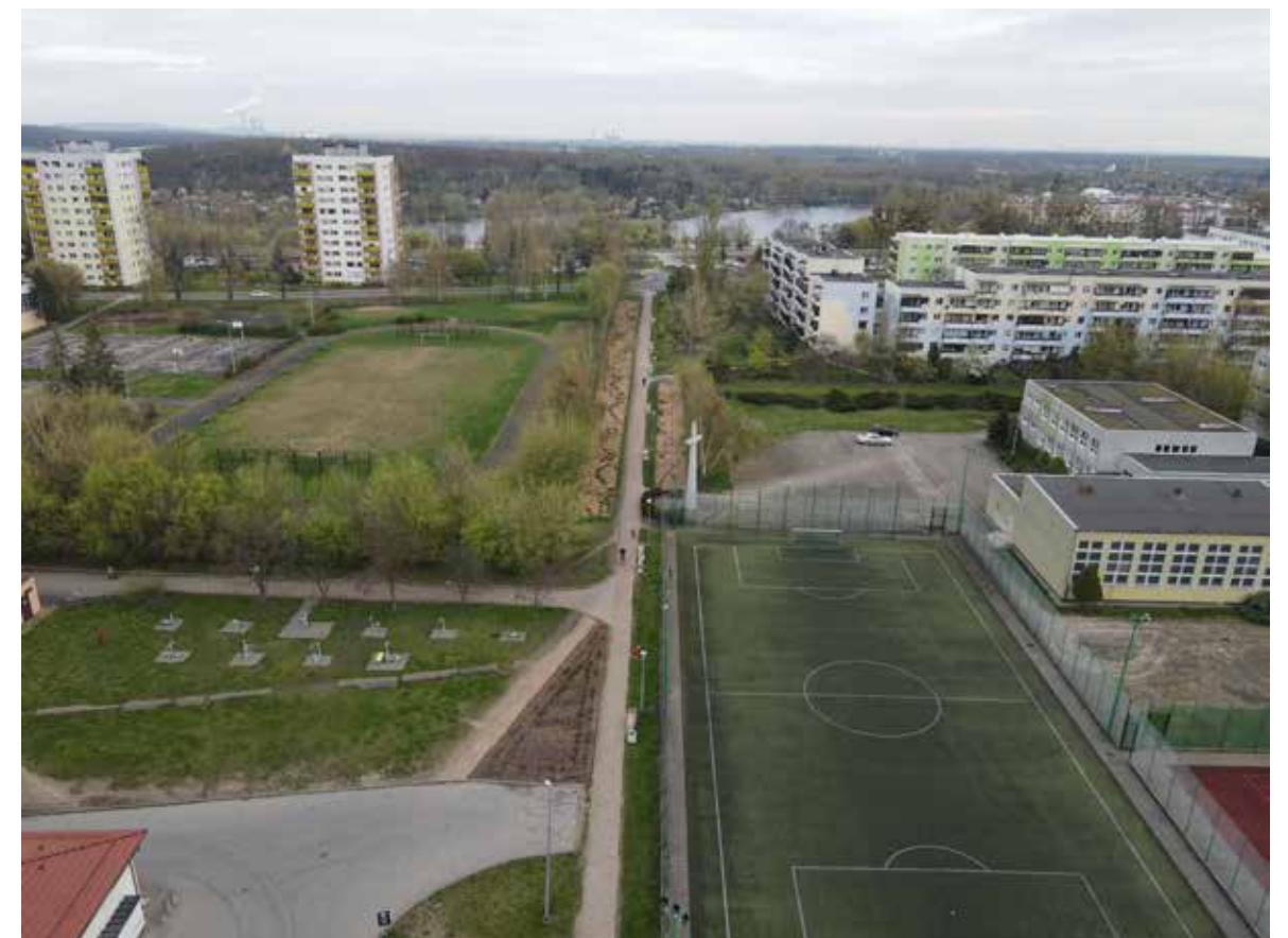
STAN PO REALIZACJI 2024
