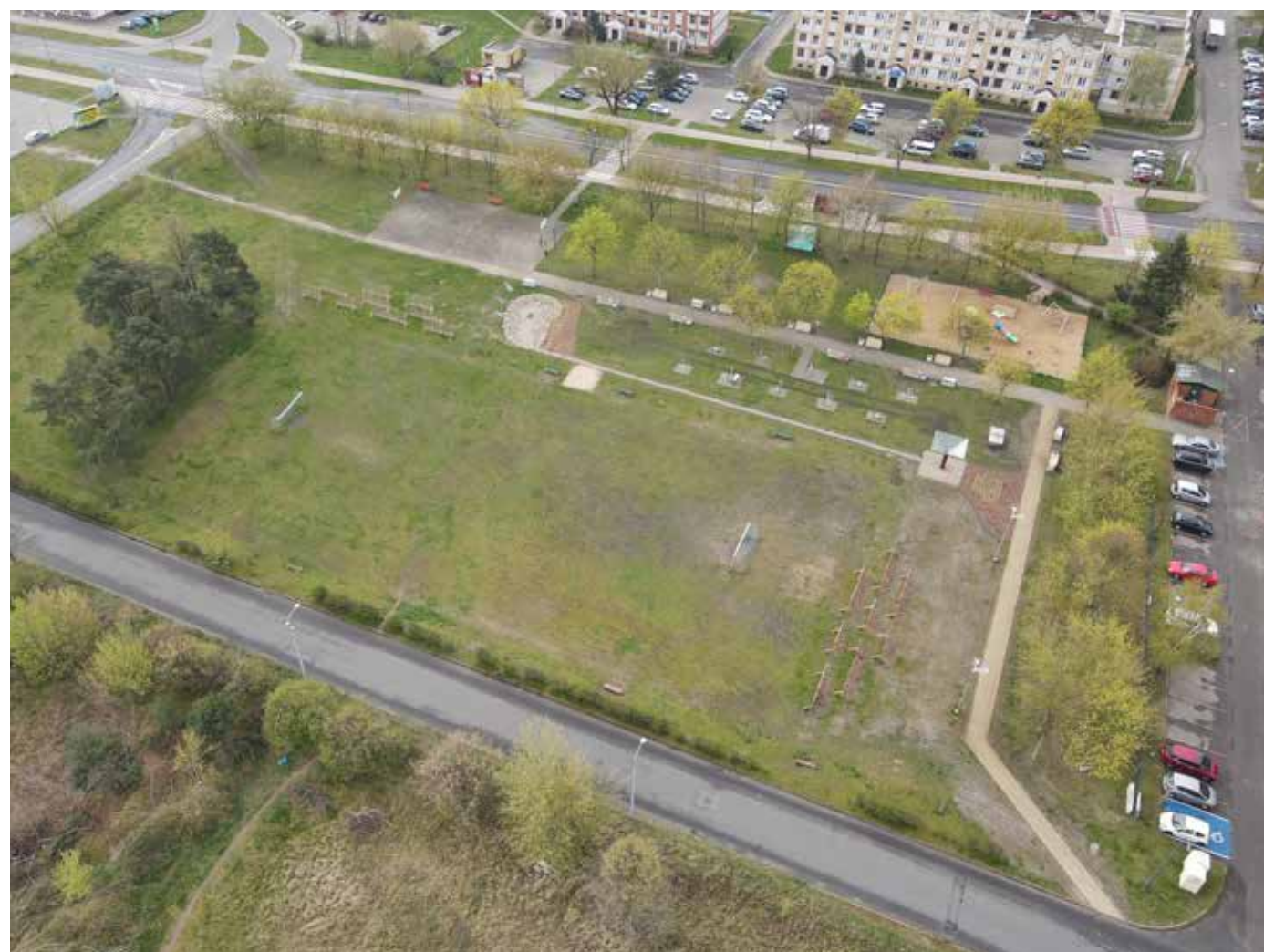
STAN PO REALIZACJI 2024
