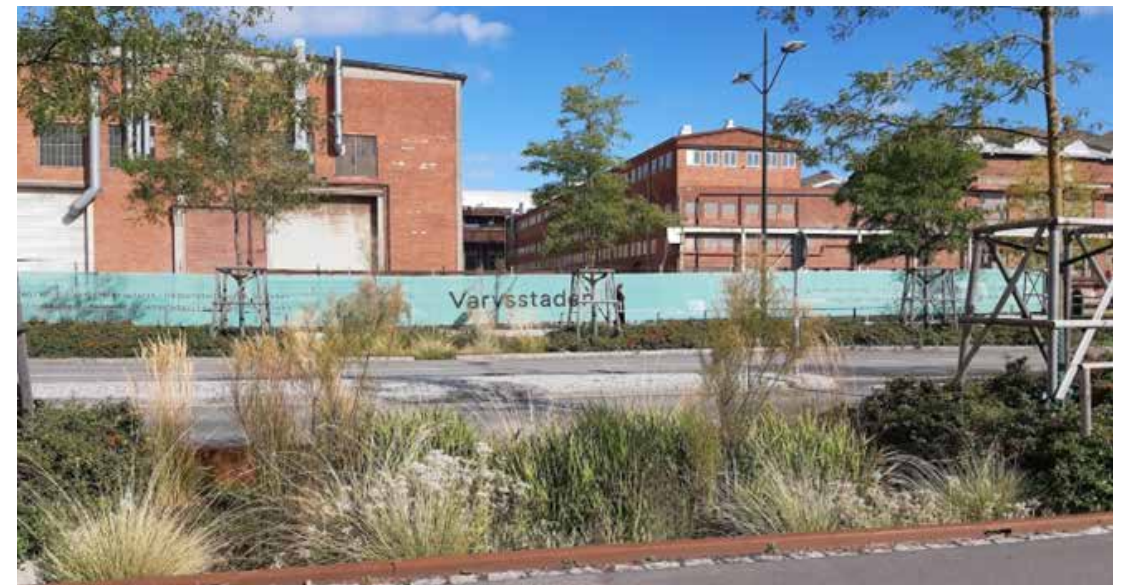
Ogród deszczowy ograniczony obrzeżami ze stali corten. Woda z ulicy wpływa wpustami wykonanymi w dolnej części obrzeży, dzielnica Västtra Hamnen Malmö
