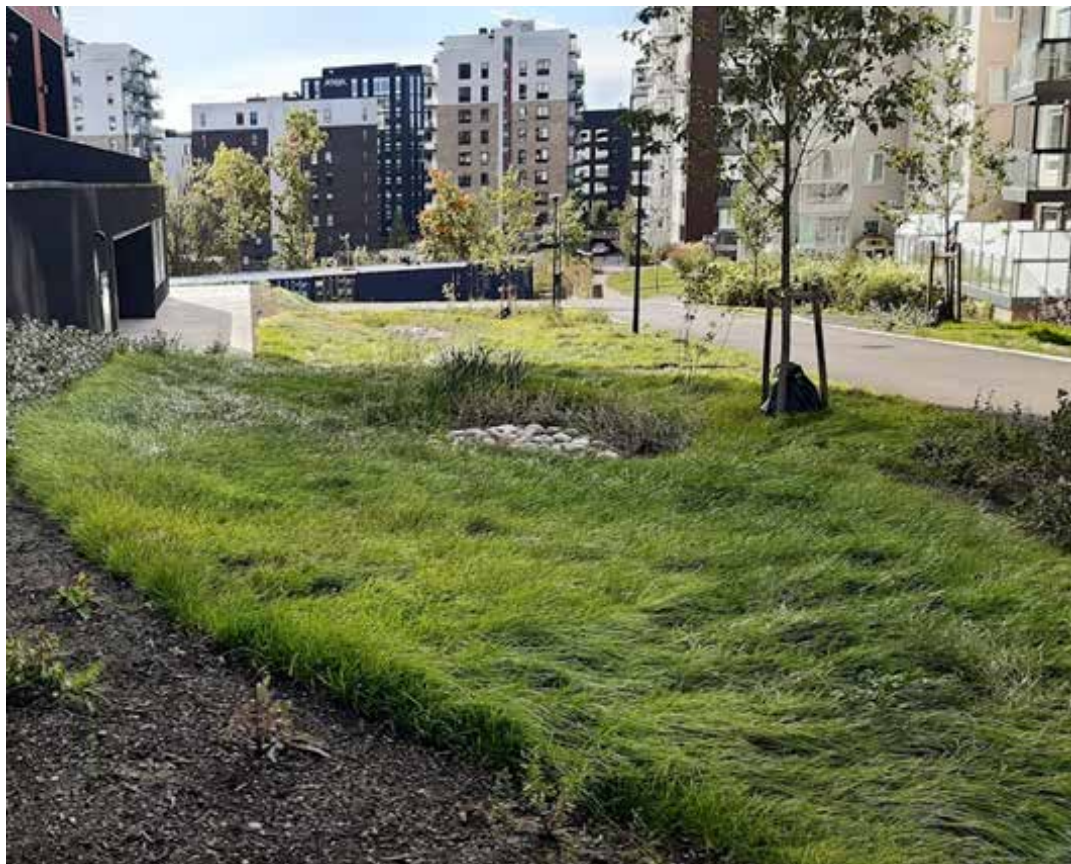
Ogród deszczowy w formie niewielkiego owalnego zagłębienia w gruncie – współczesne osiedle w Oslo
