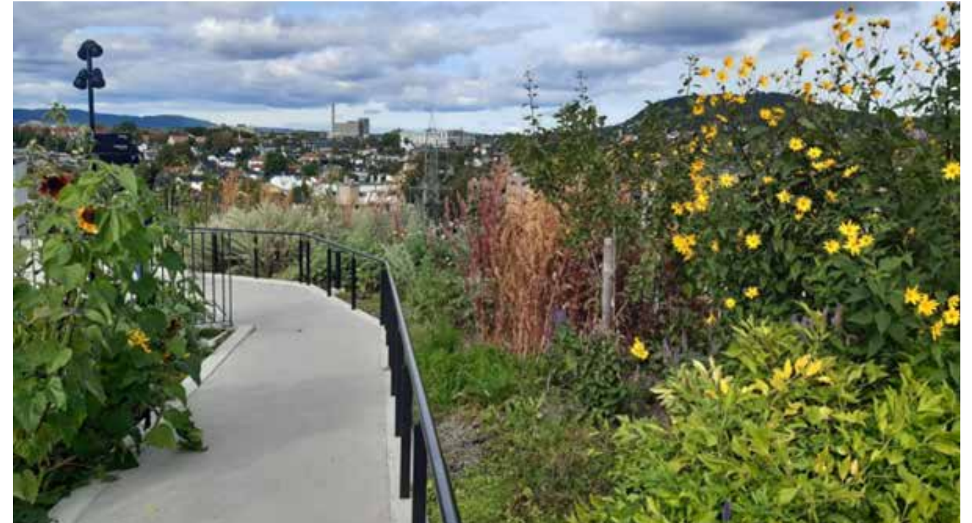
Zielone dachy mogą mieć różną postać zależnie od planowanej funkcji. Na zdjęciu ogród na dachu w wielofunkcyjnym budynku Økern Portal w Oslo.
