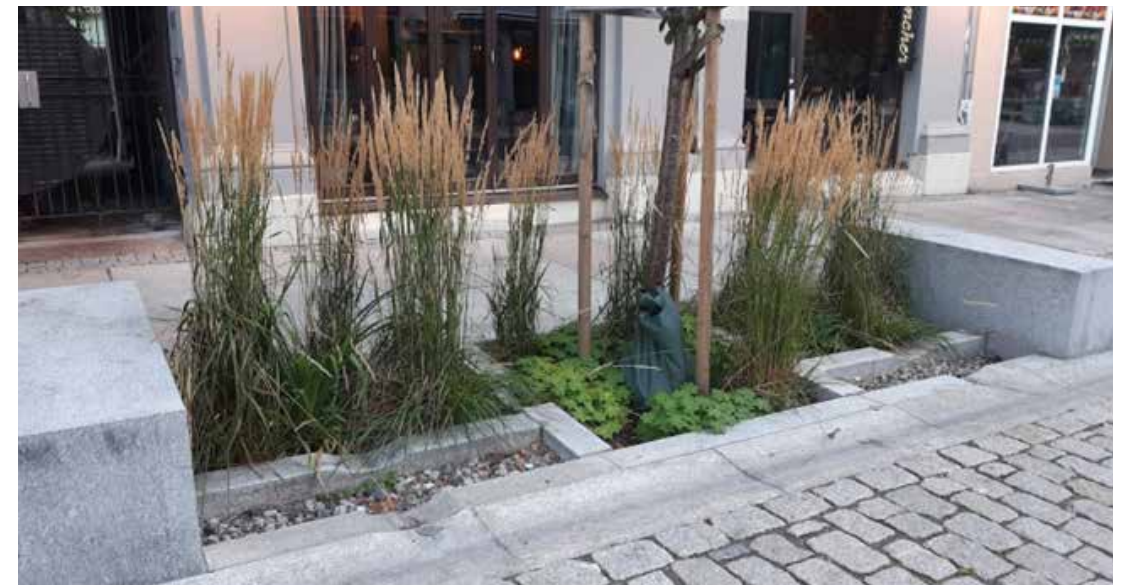
Ogród deszczowy w pasie chodnika, woda opadowa spływająca z nawierzchni utwardzonych przepływa w tym rozwiązaniu przez żwirowy filtr zatrzymujący większe osady, a następnie wpływa do części w której rosną rośliny, ulica w centrum Oslo
