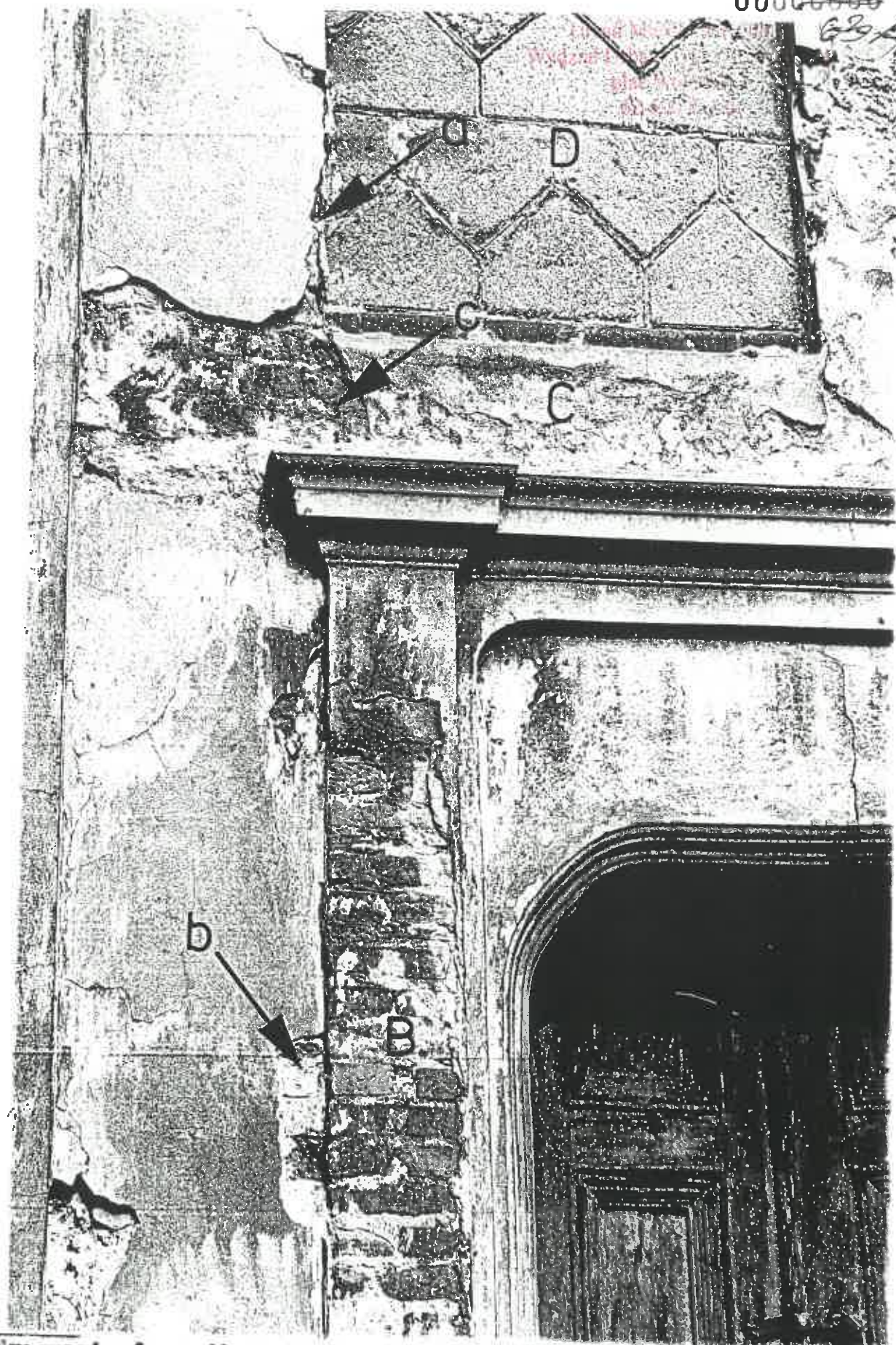
51. Fragment elewacji zach. A - mur pierwotny, nr 1,2,3 - warstwy główek o skutym licu /węzeł nr 69/, "a" - zachowane lico cegły /węzeł nr 69/, B - mur wtórny, cegła na szpr. drobnosiarnistej białej, "b" - przewiązanie muru /węzeł nr 67/, C - mur wtórny, cegła z zach. licem, "c" - szew przezielenia, D - zamurzenie pierwotnego otworu okiennego. 2 oryginałem
