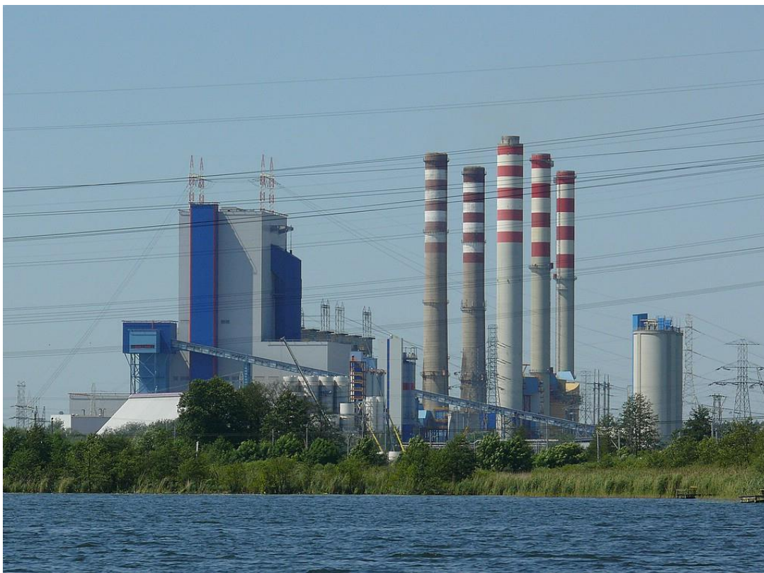
Zdjęcie 2. Elektrownia Pątnów. Źródło: https://commons.wikimedia.org/wiki/File:Elektrownia_P%C4%85tn%C3%B3w.jpg [dostęp: 12.02.2022 r.]
