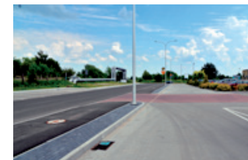
Rozbudowa ulicy Solnej
