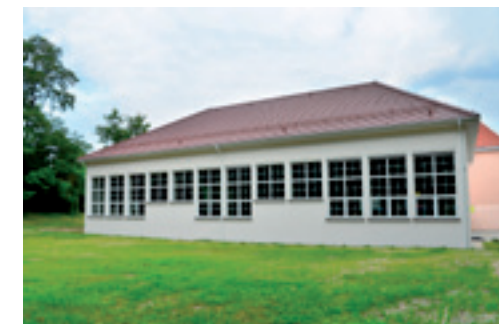
Budowa sali gimnastycznej przy Szkole Podstawowej Nr 1
