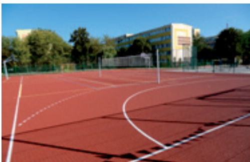
Budowa zespołu boisk przy Gimnazjum nr 7
