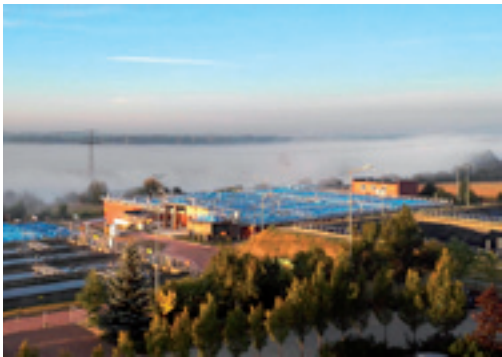
Modernizacja oczyszczalni ścieków
